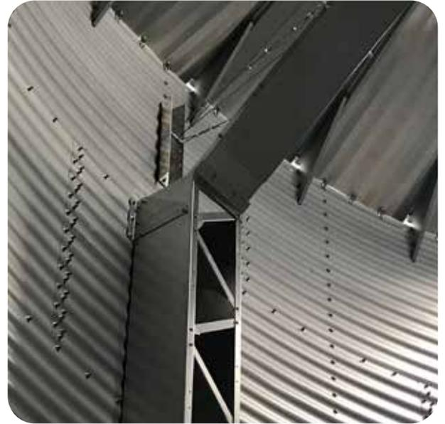
**Tobogán de descarga.** Posibilita que en la carga del silo el producto se deslice de una forma homogénea
