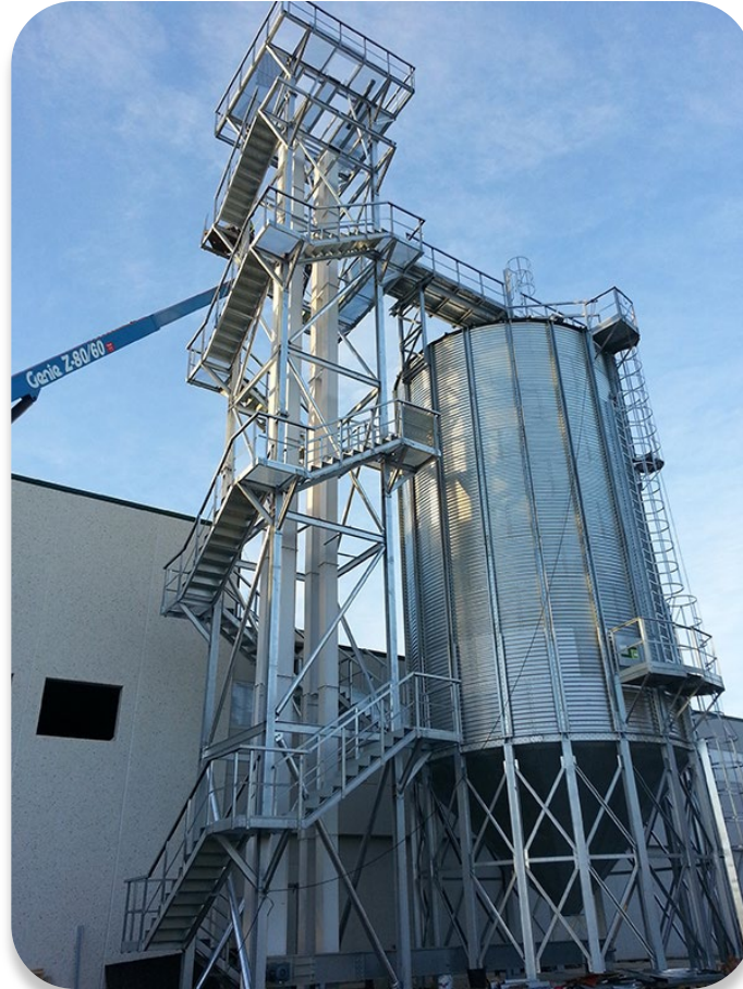
Torre de escaleras de acceso
