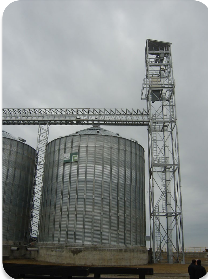
Torre intermedia, pasarela y torre de elevadores
