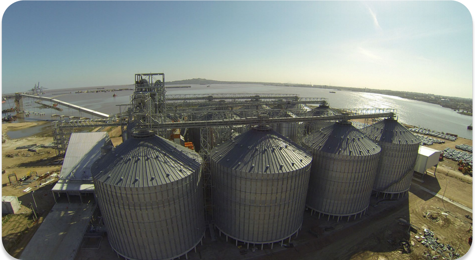
Instalación de Silos con pasarelas y torres de pasarelas
