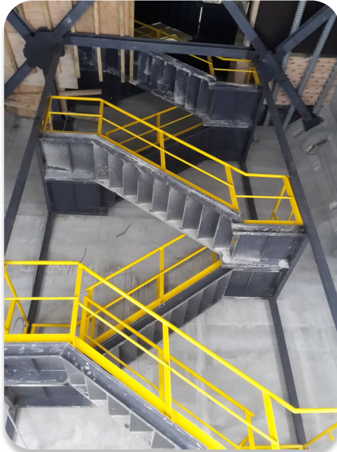
Escaleras de acceso
