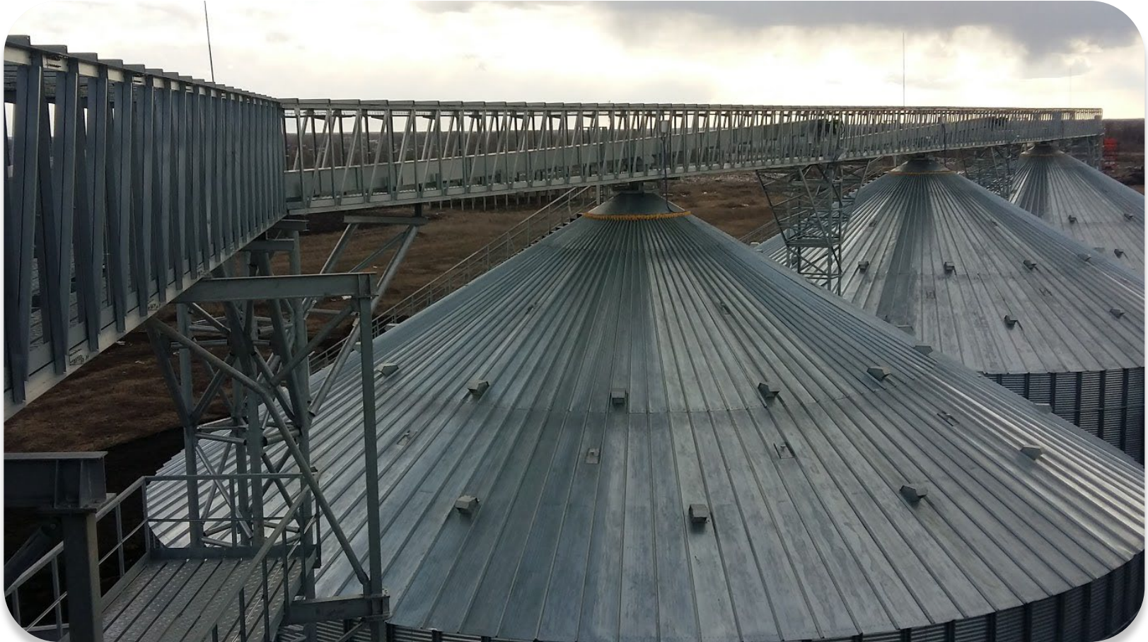
Pasarelas, torres intermedias de pasarelas
