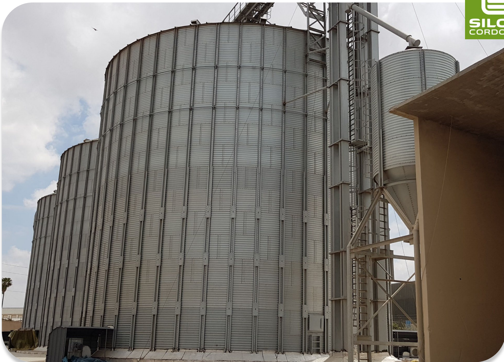
2018 SETTAT – MARRUECOS : 3 silos mod. 18,33/15 – Capacidad total: 20,000 T
