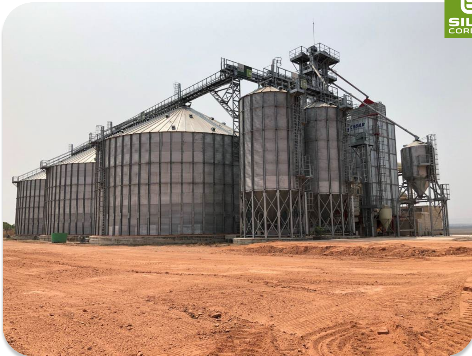
2020 MALANGE – ANGOLA: 6 silos mod. 22,92/12 - Capacidad total: 29,500 T
