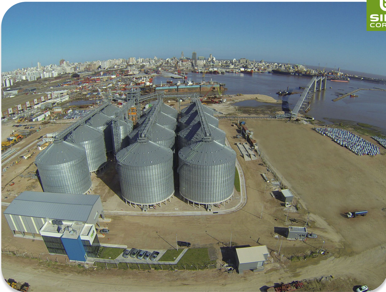
2015 OBRINEL - URUGUAY: 12 silos mod. 27,50/17 - Capacidad total: 121.000 T
