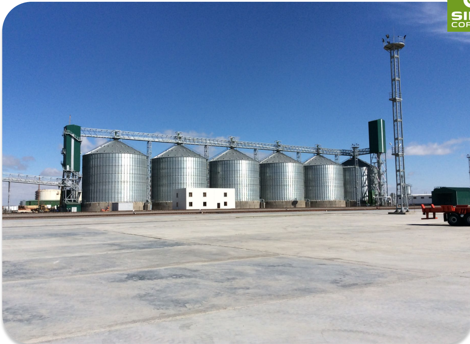
2015 AKT - KAZAJSTÁN: 6 silos mod. 27,50/18 - Capacidad total: 62.000 T
