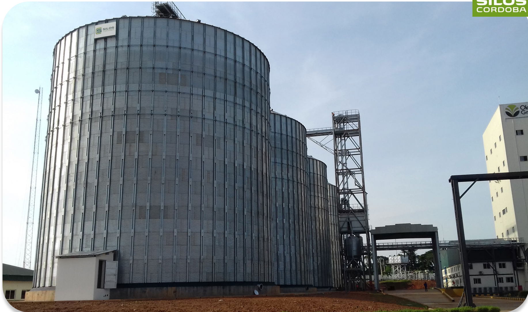
2017 NIGER05 - NIGERIA: 4 silos mod. 24,45/22 – Capacidad total: 40.000 T
