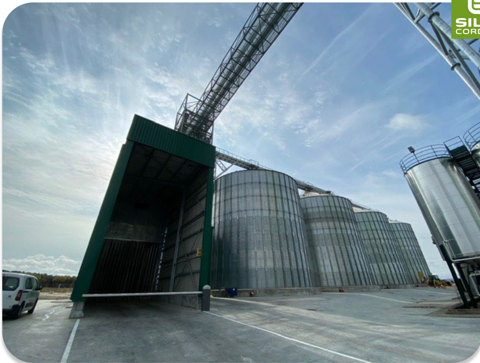
2020 ESAGROCE - ESPAÑA: 4 silos mod. 17,57/15 – Capacidad total: 14,250 T
