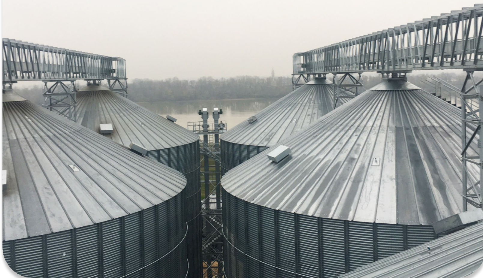
2017 CAPA COLONIA - ITALIA: 6 silos mod. 20,63/20 – 1 silo elevado mod. 9,17/19 45° – 3 silos elevados mod. 4,58/3 60° – Capacidad total: 38.800 T
