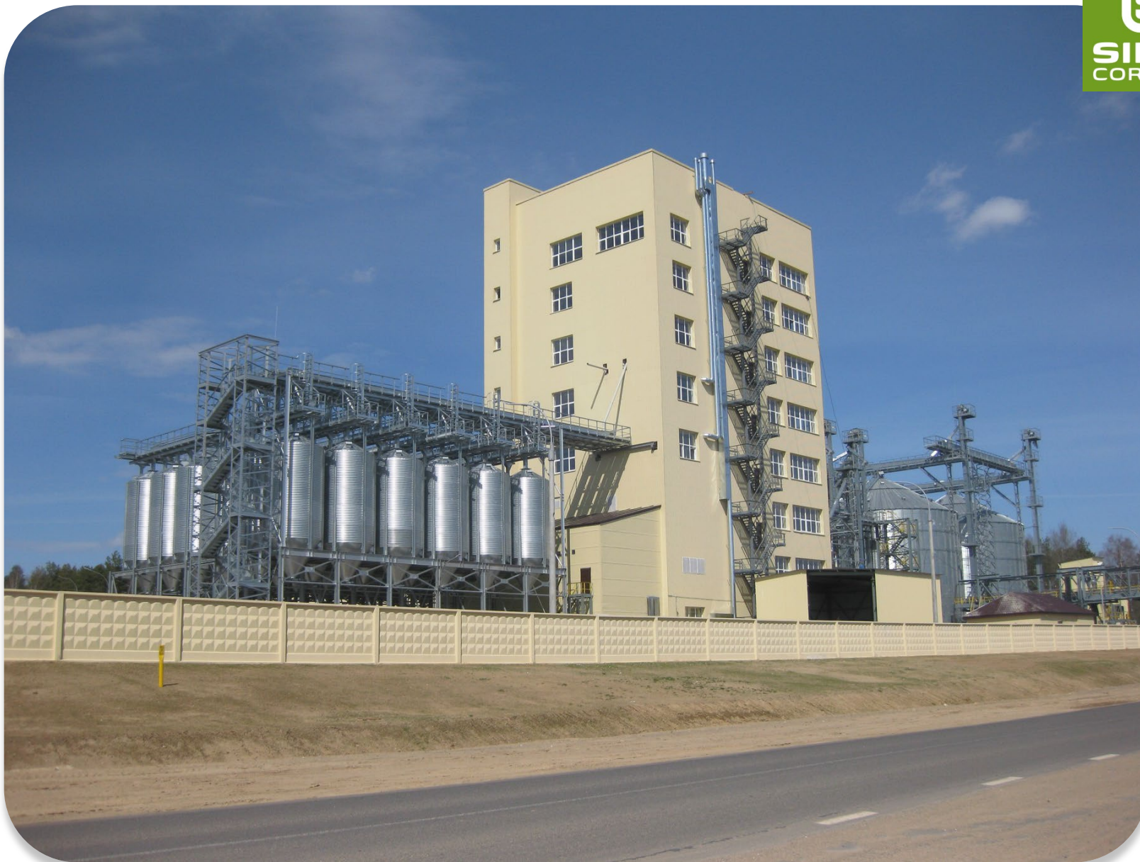
2015 VITEBSK - BIELORRUSIA: 8 silos mod. 19,10/13 – 14 silos elevados mod. 6,11/9 – 36 silos expedición 3,50/5 - Capacidad total: 33.800 T
