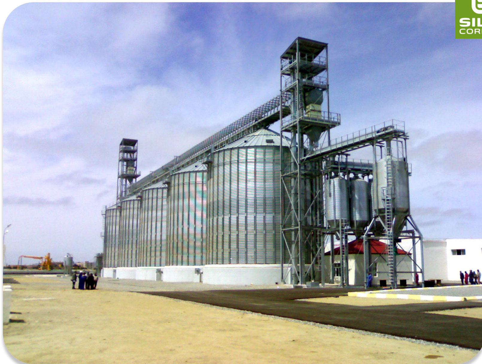
2007 BAKU - AZERBAYÁN: 5 silos mod. 16,81/14 – Capacidad total: 15.000 T
