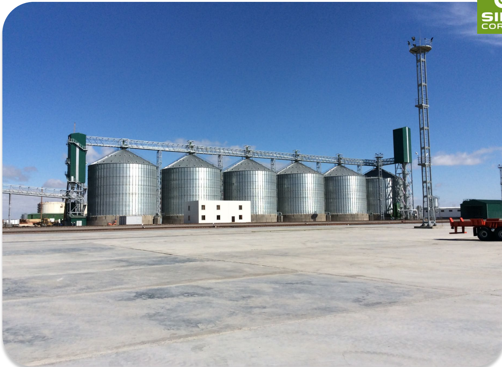
2015 AKT - KAZAJSTÁN: 6 silos mod. 27,50/18 - Capacidad total: 62.000 T
