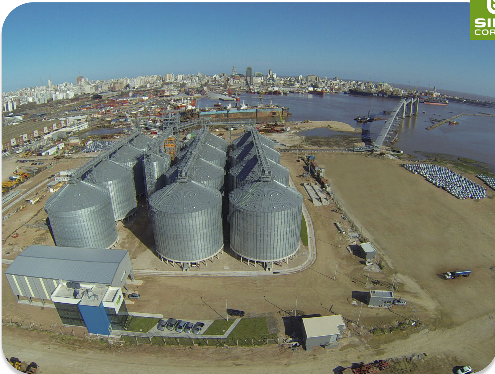
2015 OBRINEL - URUGUAY: 12 silos mod. 27,50/17 - Capacidad total: 121.000 T
